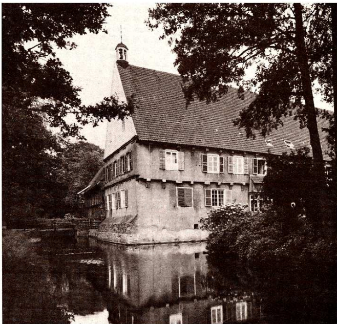
Fensterläden, Dachsimse, Hohlräume von Mauerverkleidungen und Zwischenböden können Fledermäusen als Tagesquartier dienen. Unerläßlich sind Einlässe wie Mauerlücken, Holzspalten, schiefe Dachpfannen oder Fluglöcher im Giebel. Burg Dinklage.
