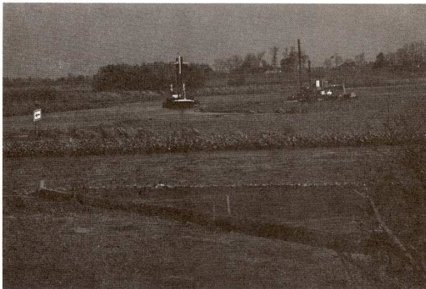
Schlickentnahme durch Saugbagger im Mündungsbereich der Schleife für Deicherhöhung
