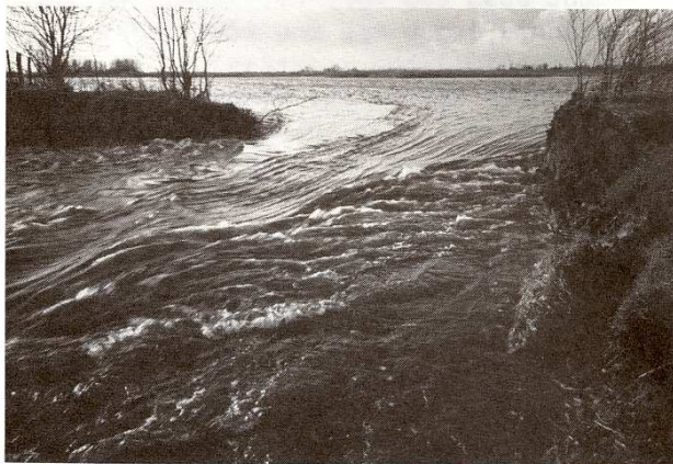
Bruch eines Sommerdeiches bei Vellage
