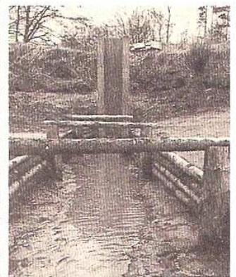
Abb. 3–5 – Zuleiter im Sommer mit Beständen aus Schlank-Segge ( Carex gracilis ) und blühendem Froschkraut ( Luronium natans ), oben. Entwässerungsgraben eines abgelassenen Teiches mit einem Betondurchlaß („Mönch“), unten. Das mittlere Bild zeigt einen in der Abendsonne liegenden Teich.
