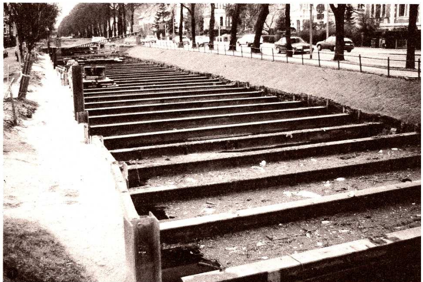
1 Wasserbau an der Haaren in der Stadt Oldenburg (Oldbg.) zwischen der Ofener Straße und dem Haarenufer. Nachdem – abweichend vom Plan – zu tief gebaggert worden war, bewegten sich die Spundwände dachartig zur Mitte. Insbesondere im Bereich der alten Mäander kam es zu Veränderungen. Um denkmalgeschützte Häuser abzusichern, wurden aufwendige Verstrebungen und Kanalbetonierungen vorgenommen. 12. Juli 1987.
