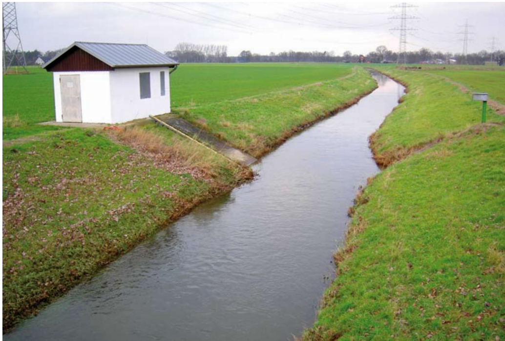
4 Hunte zwischen Bohmte und Hunteburg; im Haus befindet sich ein Messpunkt des Landesbetriebs für Wasserwirtschaft (NLWKN Cloppenburg), in dem regelmäßig hydrologische Daten erfasst werden.
