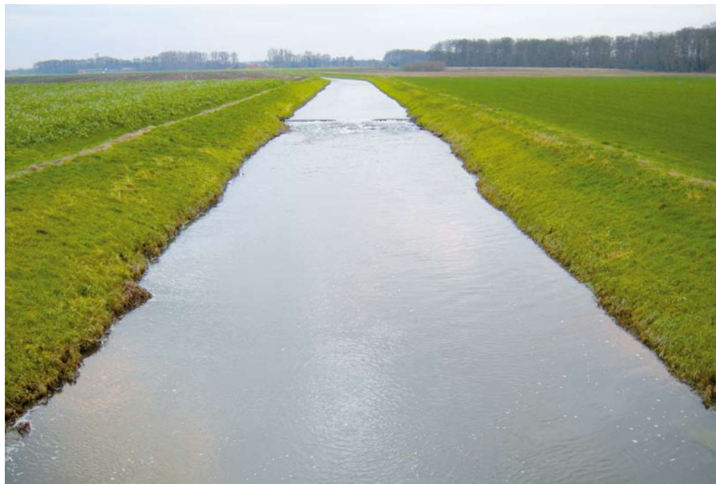
1 Blick auf die kanalisierte obere Hunte heute – flussaufwärts in Richtung Bohmte. Am Horizont das Wiehengebirge im Bereich Bad Essen-Wittlage und Melle. Die Sohlschwelle verlangsamt die Fließgeschwindigkeit der zum Betrachter fließenden Hunte. Flussabwärts befinden sich in Hunteburg die Römerbrücke und – anstelle eines früheren Wehrs – die breite Fischtreppe der Niedersächsisch-Westfälischen Anglervereinigung. Der Vorschlag zur Revitalisierung betrifft diesen Abschnitt. FOTO: CHRISTOPH WONNEBERGER
