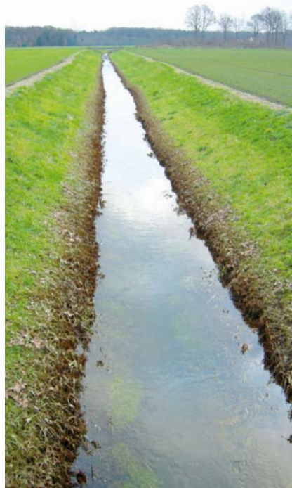
2 Ein Seitengewässer der Hunte, die Gräfte, vor der Einmündung in die Hunte als "Hauptvorfluter". Die Böschungen sind – wie auch auf den anderen Bildern zu sehen – komplett gemäht, um einen zügigen Wasserabfluss zu gewährleisten. Das trapezförmige Profil begünstigt die Unterhaltung, ist aber gewässerökologisch negativ zu bewerten.
