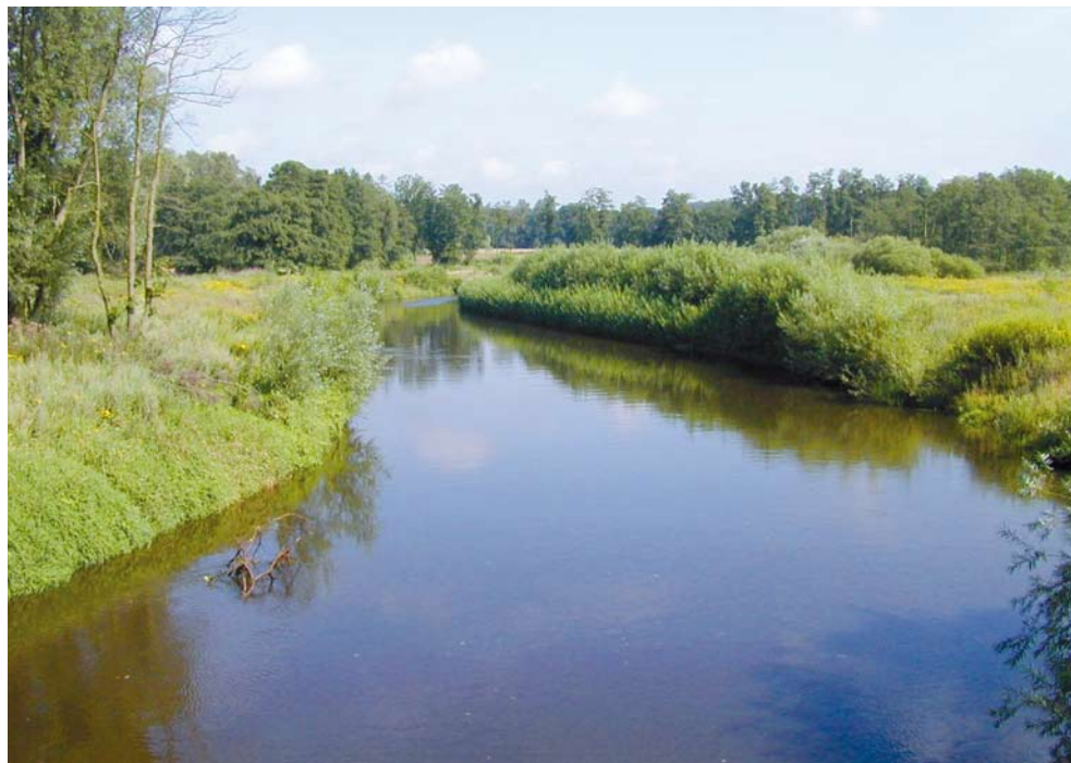
8 Die neu gebaute Hunte Schleife bei Dötlingen, vier Jahre nach der Baumaßnahme, möglicher Aspekt einer landschaftsgerechten Renaturierung an der Oberen Hunte.
