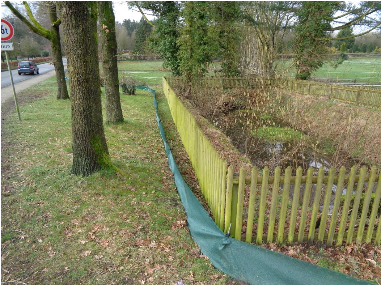
Krötenschutzzaun mit Durchlass unter der Straße. Foto: BSHnatur
