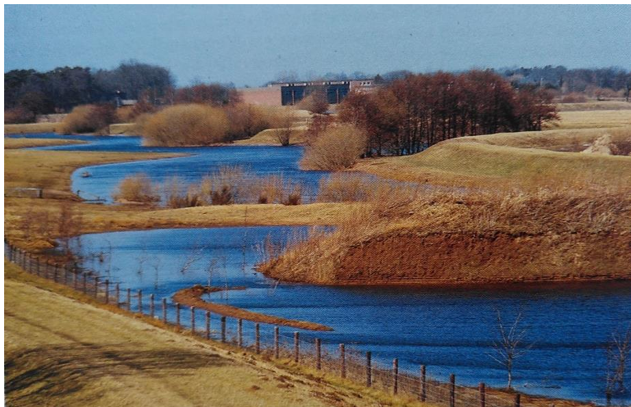
Renaturierung des westlichen Hunteufers unterhalb der A 29-Querung durch die Hunte-Wasseracht nördlich der Raststätte „Huntetal-West“. Um ein besseres Durchflussprofil und einen größeren Stauraum zu erhalten, wurde der Deich (nach links, also westlich) verlegt. Im neuen Außendeichsbereich entstanden eine Steilwand und zwei Teiche. Hochwasser läuft über eine Schwelle von unterhalb ein, um die Versandung in Grenzen zu halten. Aufgenommen am 27. März 1987. Aus: Die Hunte. Portrait eines nordwestdeutschen Flusses (BSH), s.o., S. 82. Foto: BSH
