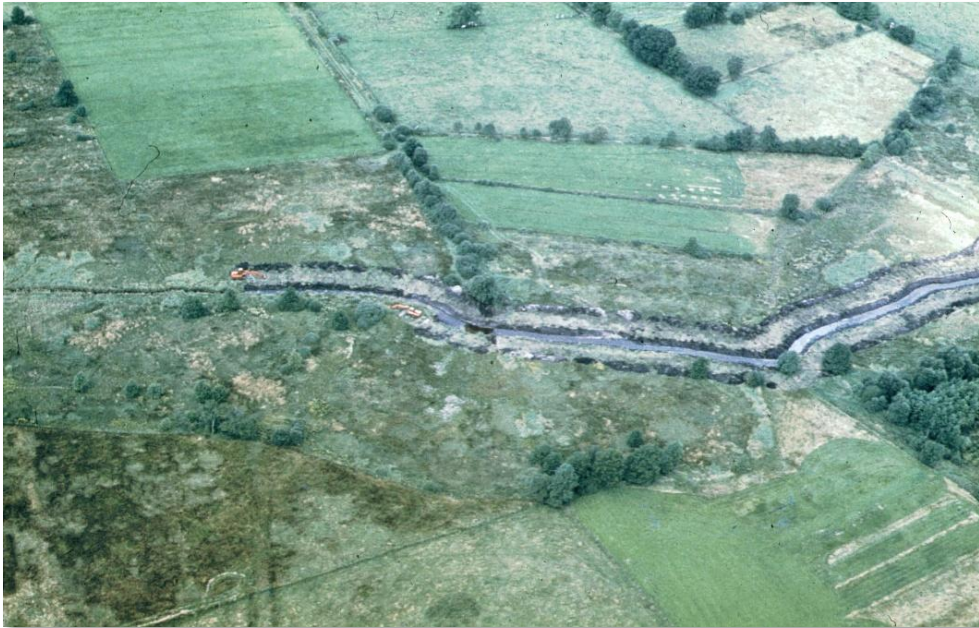
Baggerarbeiten an der Marka Ende der 1970er. Zwei Bagger vertiefen das bislang naturnahe Gewässer und heben das Baggergut mit Laichkräutern auf die Ufer. Foto: BSH-Archiv
