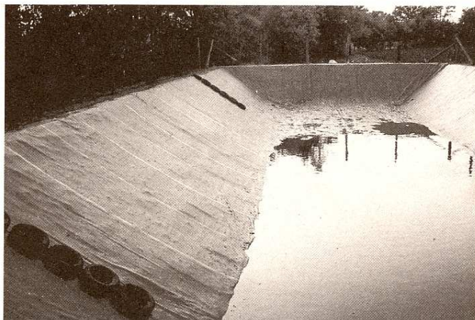
17 Gülle-Lagunen sind folienausgelegte Hochbehälter zur vorübergehenden Lagerung für Flüssigmist mitten in der Landschaft, hier kurz nach der Fertigstellung. Der Naturschutz lehnt sie ab, da die Sichtbrunnen unwirksam gebaut sein könnten, der Folie nur 10 Jahre Festigkeit gegeben wird und weitere Emissionsquellen verbreitet werden.
