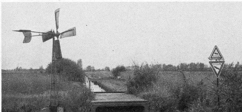
2 Qualmwassergräben, Ring- und Zugggräben inmitten einer Feuchtwiesenlandschaft des östlichen Dümmer-Ufers (Hohe Sieben) werden mit Windpumpen hoch angestaut. Im Vordergrund ist die Stauanlage mit Überlauf zu sehen. Das Gefälle ist minimal.
