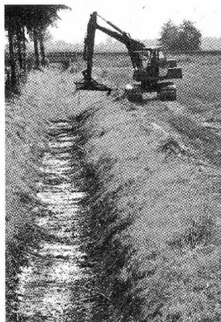
13 Schonende Grabenpflege durch einen Hydraulikbagger mit Korb. Das flach abgezogene Kraut wird am Ufer deponiert, so daß Lurche, Insekten und Kleinorganismen die Möglichkeit haben, in das Gewässer zurückzukriechen. Rotations-Fräsen sind leistungsfähige, aber unzulässige „Mordinstrumente“. Zur Eindämmung der Wasserverschmutzung mit Bioziden und Gülle sind beidseitig 5 m breite Streifen von jeglicher Nutzung freizuhalten.
