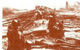
Eingeschlagene Wallhecke vor der Totalrodung und Einplanierung
