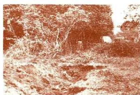
Gehölzrodung während der Vegetations- und Brutzeit zur Anlage eines Grabens
