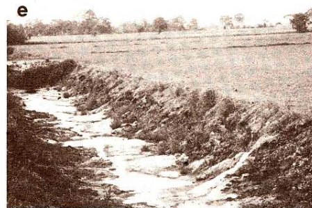
14 Die Reaktion von Boden und Böschungen sind nach dem Grabenbau und Tiefpflügen oft nicht vorhersagbar, so daß teure Reparaturen erforderlich werden. Wasserzug der Fb Hatshausen mit auseinanderfließenden Böschungen.
