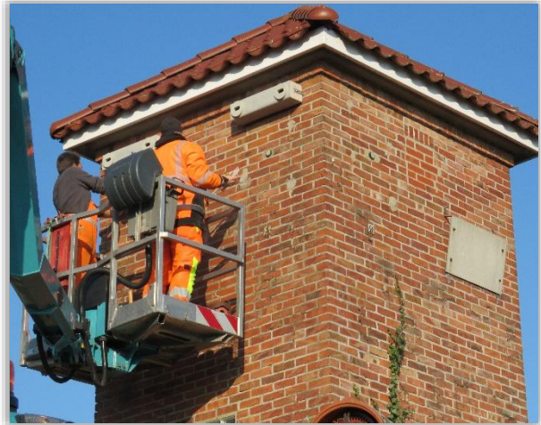
Bauhofmitarbeiter im Hubwagen am Trafoturm.
