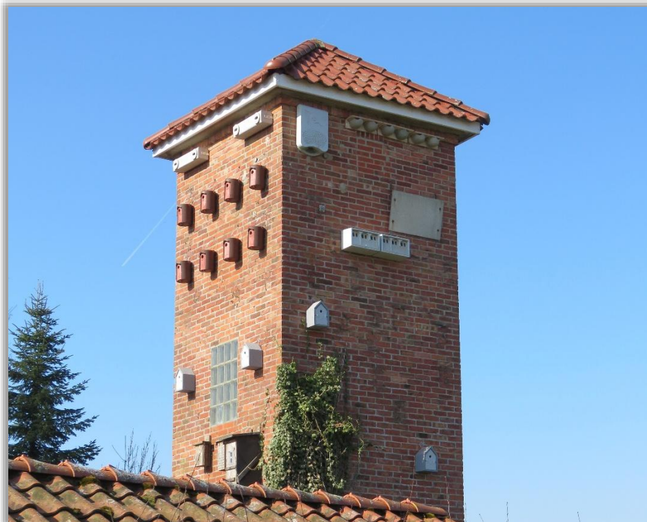
Ehemaliger Trafoturm mit neuen Nisthilfen für Koloniebrüter. Fotos: BSHnatur
